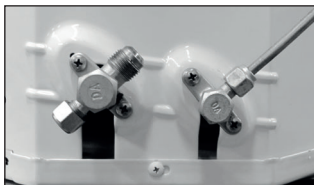
FIG. 59 - CONEXÃO DA LINHA DE EXPANSÃO DA UNIDADE CONDENSADORA
