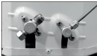
FIG. 79 - CONEXÃO DA LINHA DE EXPANSÃO DA UNIDADE CONDENSADORA
