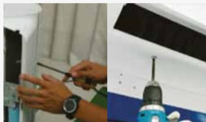
Há parafusos para prender diversas partes. O interior não pode ser acessado sem antes remover esses parafusos.
